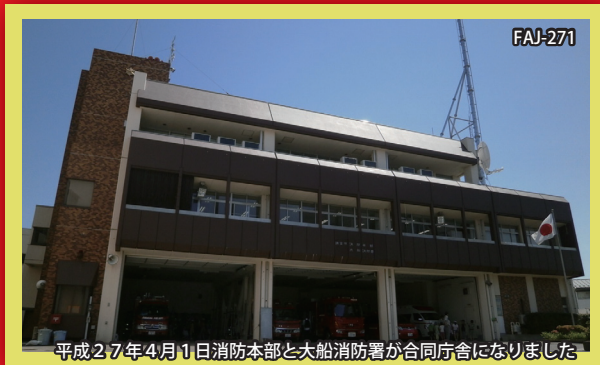
平成27年4月1日消防本部と大船消防署が合同庁舎になりました
