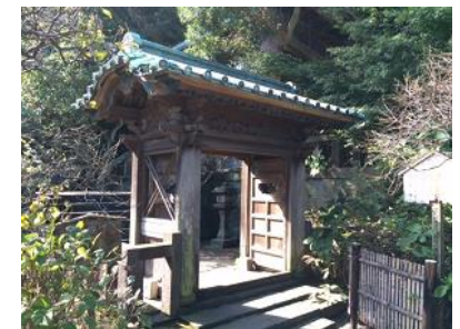
写真1-49 英勝寺 祠堂門
