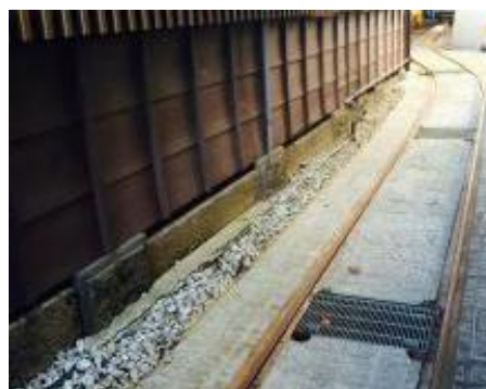
写真2-83 トロッコ用レール
