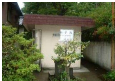
写真6-6 施工例(改修前)
