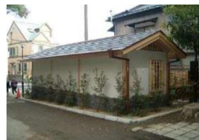
写真6-7 施工例(改修後)
