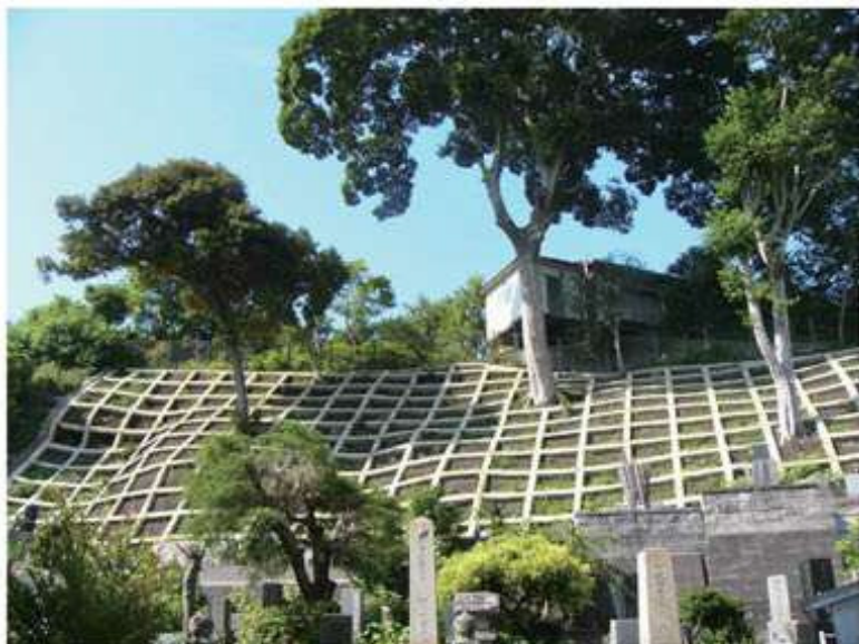
法枠工法による急傾斜地崩壊対策工事
