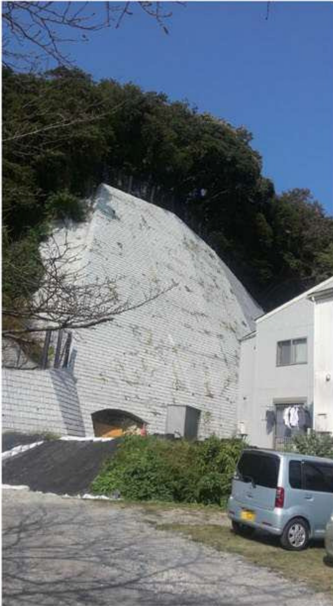
コンクリート張工による急傾斜地崩壊対策工事 ツタは成長途中
