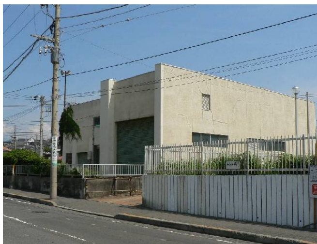
七里ガ浜中継ポンプ場
