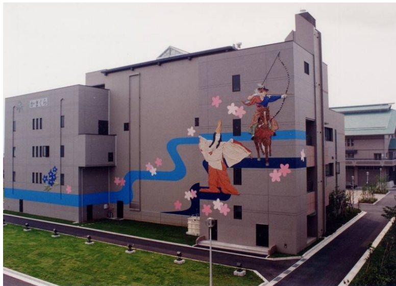
山崎水質浄化センター（汚泥焼却設備棟）
