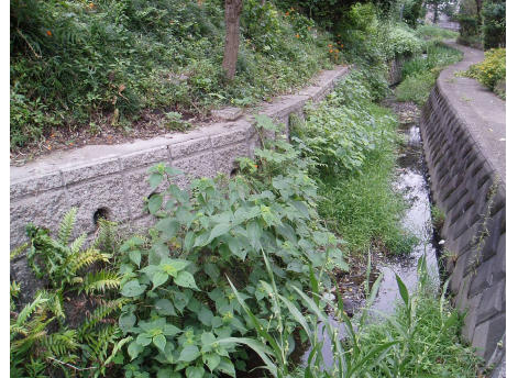
ホタルブロックの施工例
