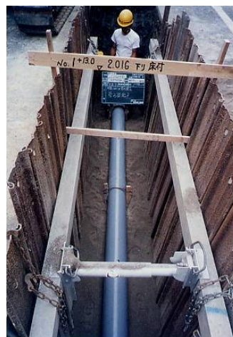
汚水管渠の布設状況
