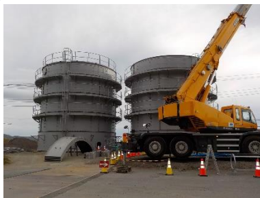
一時貯留タンク
