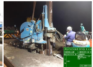
矢板打込み中の様子
