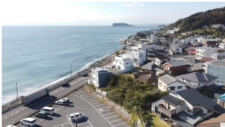
極楽寺ポンプ場上空から江の島を望む
