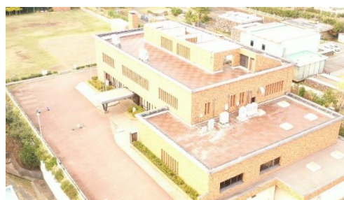
七里ガ浜浄化センター
