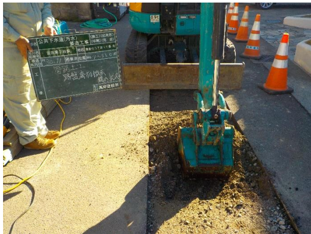
開削工法による掘削状況
