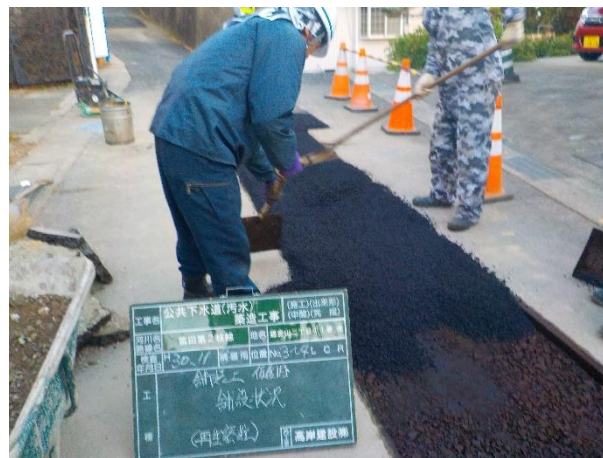
舗装復旧状況
