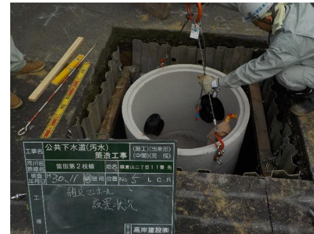
マンホール据付状況
