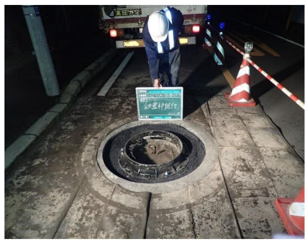
⑤受枠設置状況
