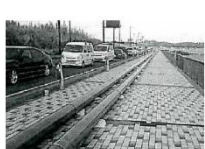
仮設の送水管の設置状況
