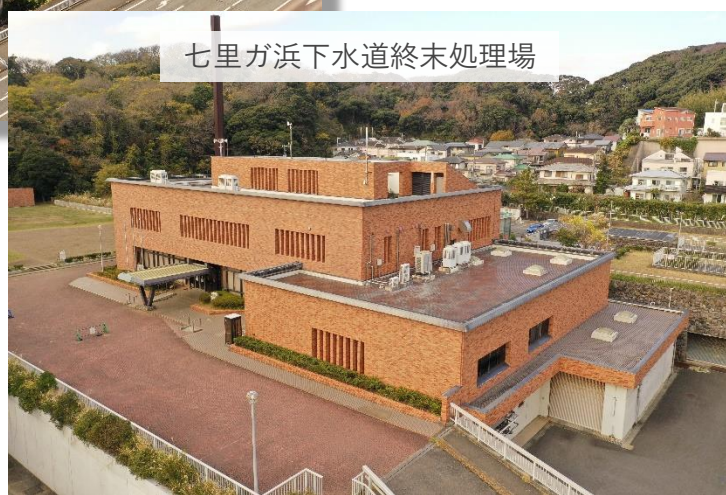
写真 下水道終末処理場
