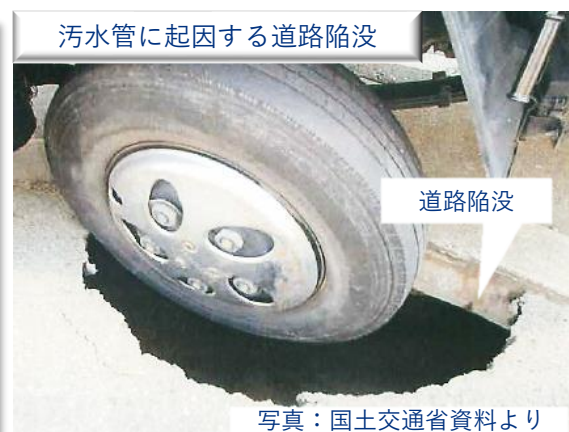
写真 污水管渠の破損状況
