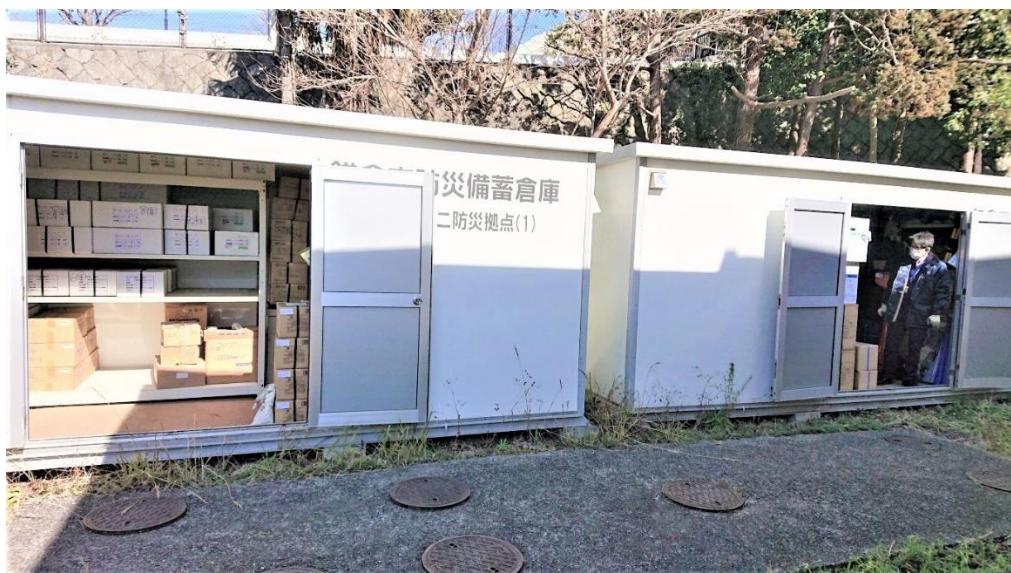
【写真1】 備蓄倉庫2棟を横に並べた標準的な配置例（深沢中学校）
