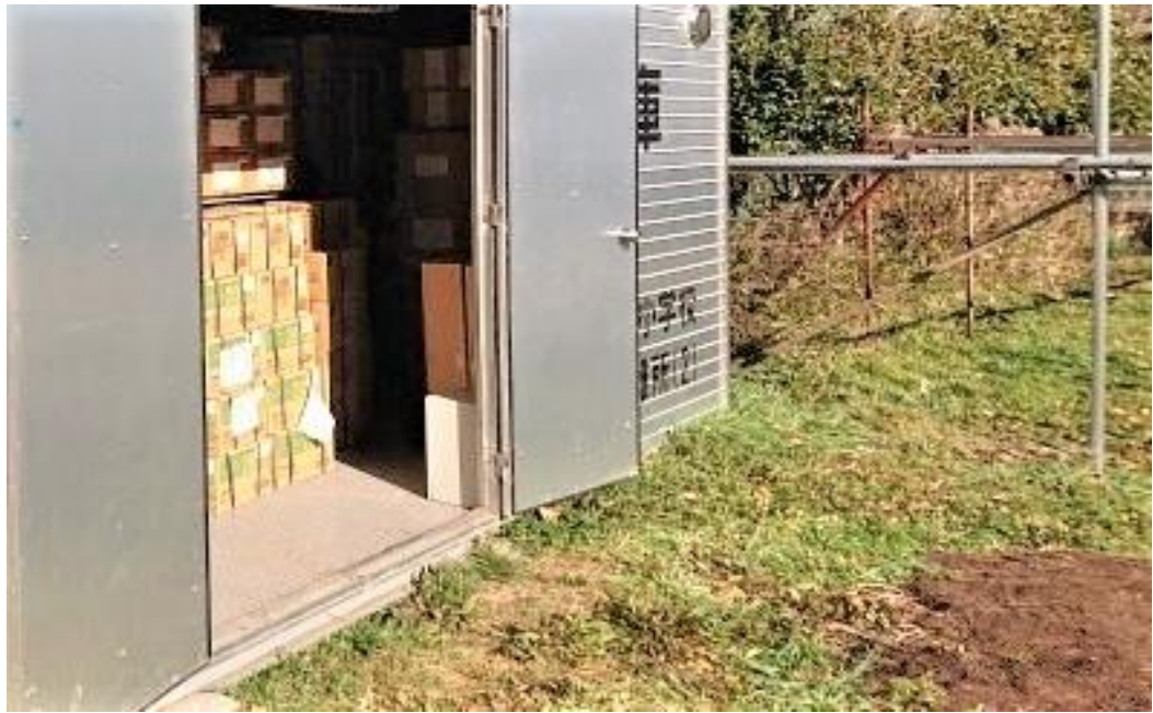
【写真4】柔らかい土の上に設置された備蓄倉庫（稲村ヶ崎小学校）
