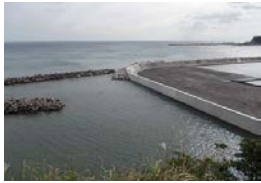
平成26年に完成した腰越漁港
