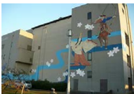
山崎浄化センター
