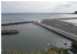
平成26年に完成した腰越漁港
