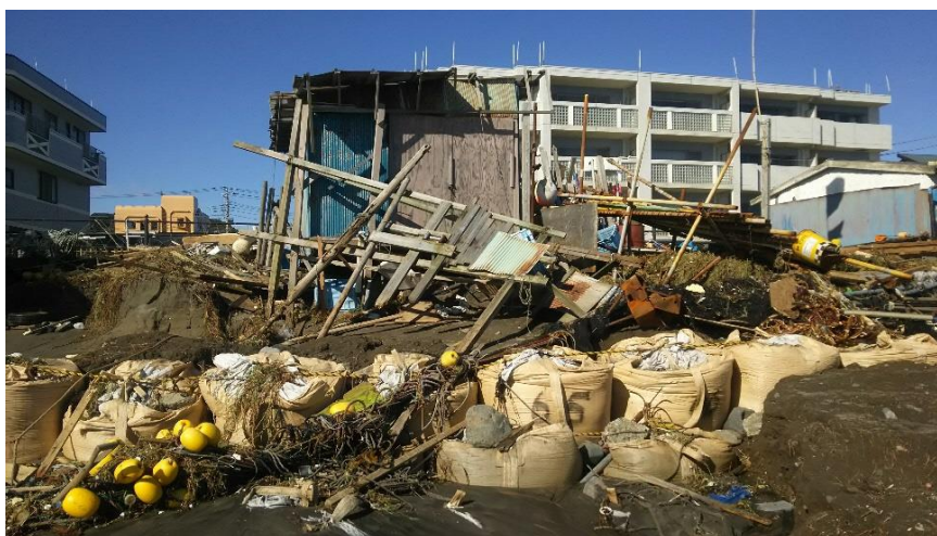
〔坂ノ下地区の漁具倉庫の被害状況〕
