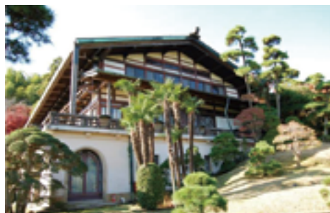
母屋は木造2階、地下1階の構造。2階には接待用のサロンがあった
