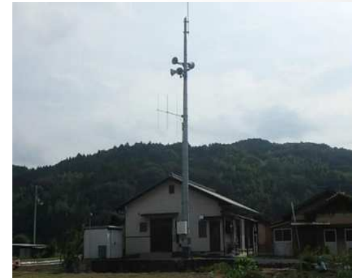
<屋外放送設備>
