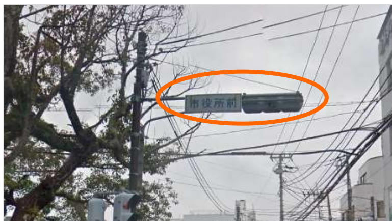
図 3.2-75 道路標識（信号交差点名板）の例
