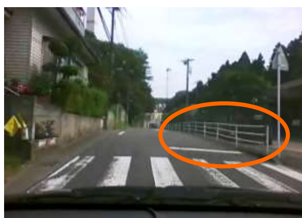
図 3.2-79 ガードパイプの例
