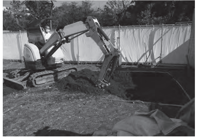
1-2 表土掘削状況
