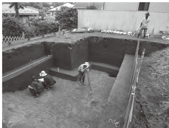
8. II区 測量作業状況 (南西から)
