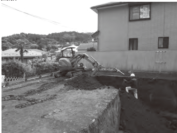
1. II区 表土掘削状況 (西から)
