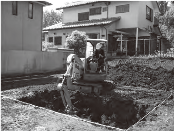
2. I区表土掘削状況 (北西から)
