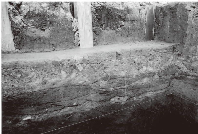
◁ 1. 調査区西壁①(東から)
