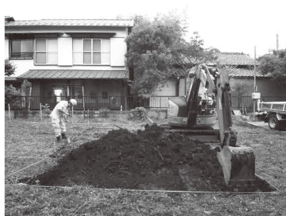
2. I区 表土掘削状況 (南から)
