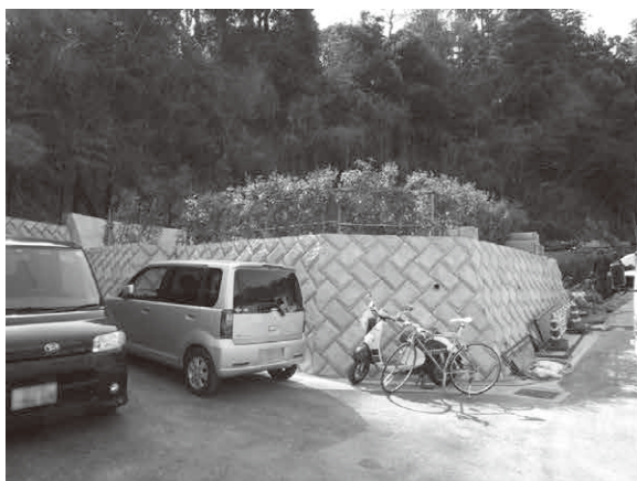
1. 現地調査前（南東から）
