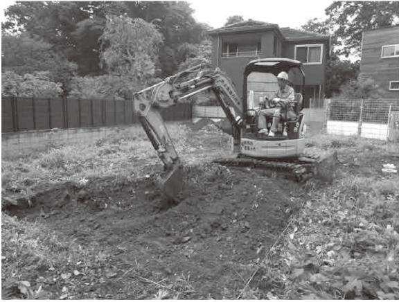
2. I区 表土掘削状況（南東から）
