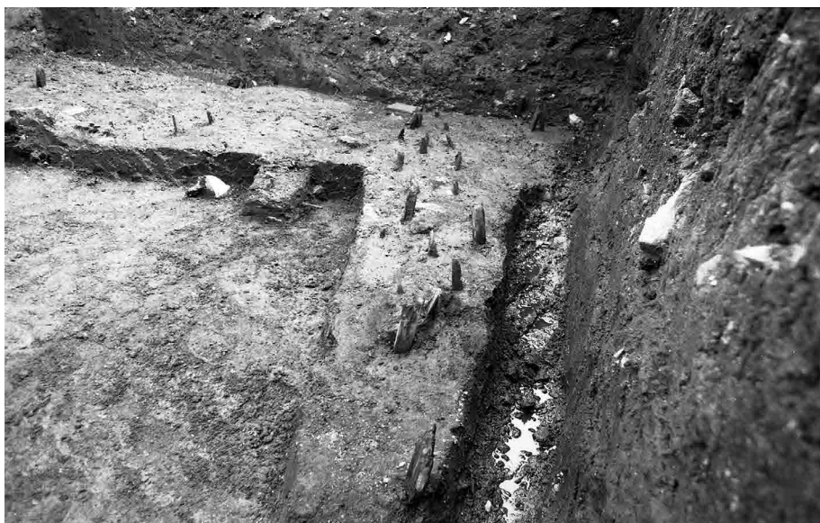
3. 第5面 杭列 1 (西から)
