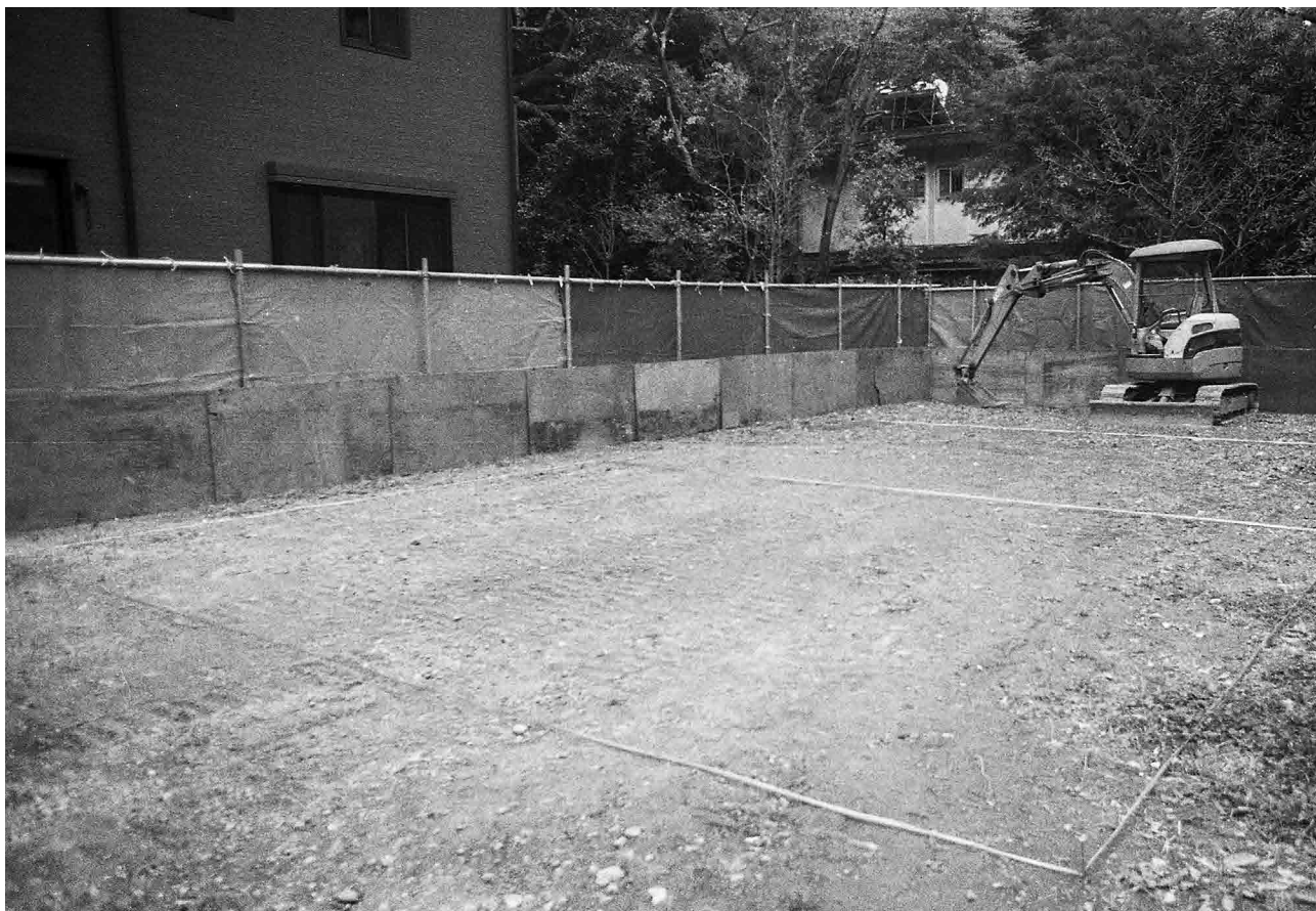
1. 調査区近景(南東から)
