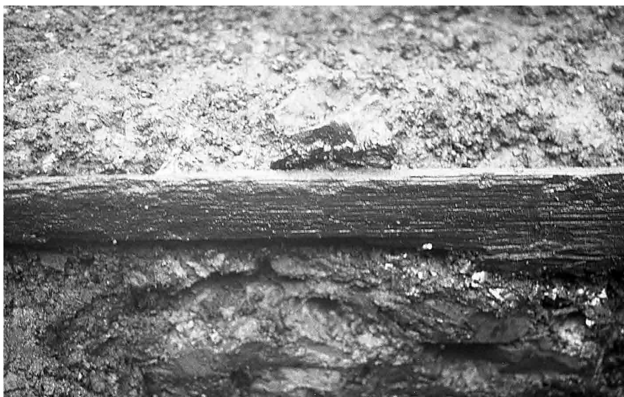
2. 第6面 礎石・礎板建物6壁板(南から)
