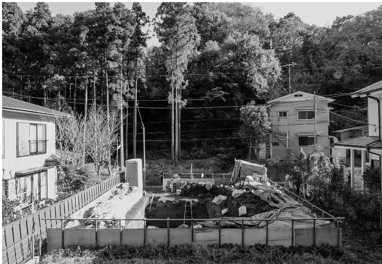
1. 調査区近景(西から)
