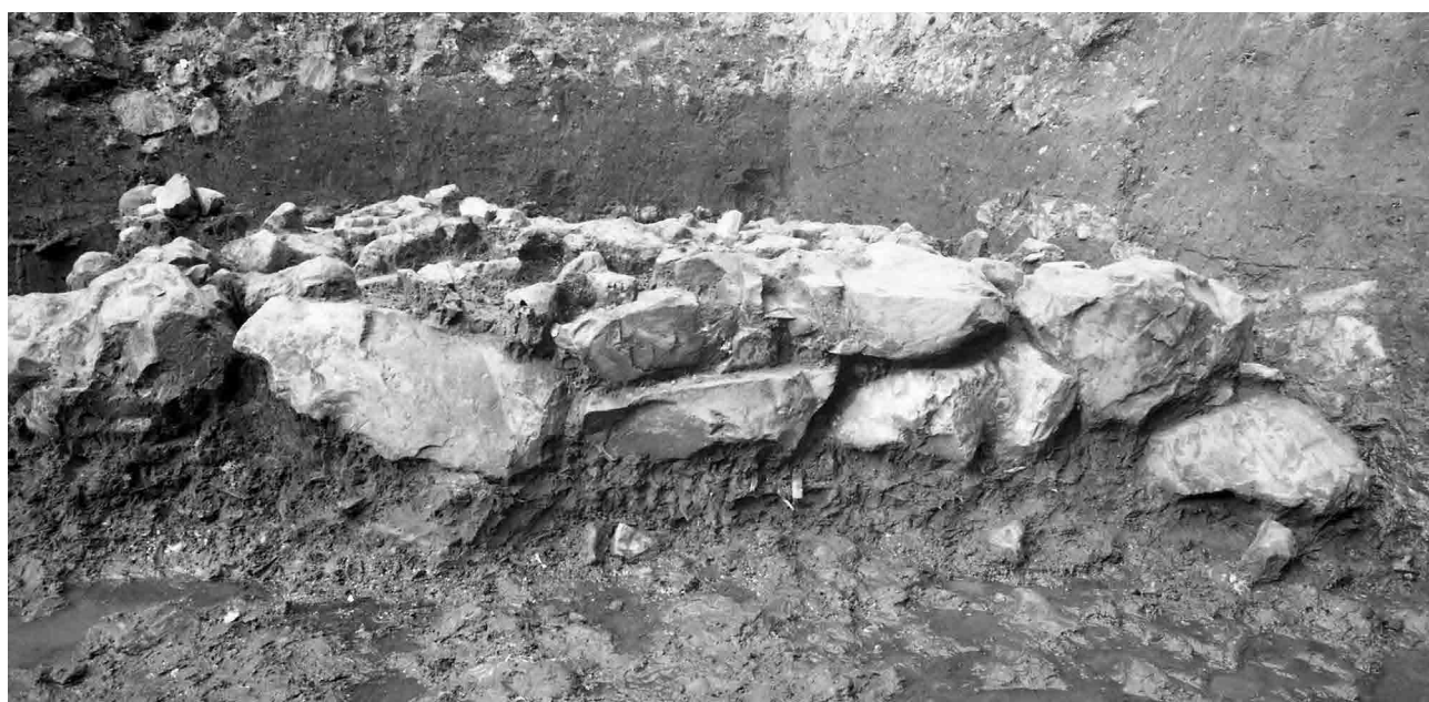
3. 第2面 河川3 護岸跡 (南から)
