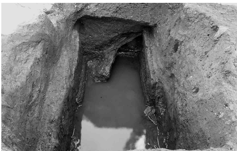
2. 第3面 木組遺構1(西から)
