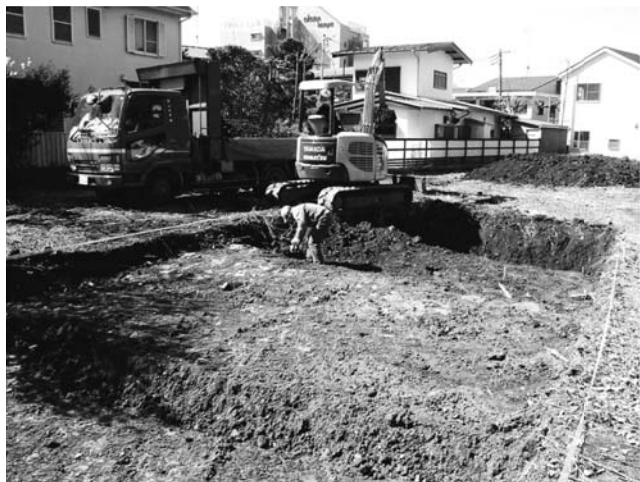
1. 地点Ⅱ 表土掘削作業（北東から）
