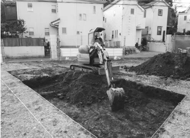
2. I区 表土掘削状況（北西から）
