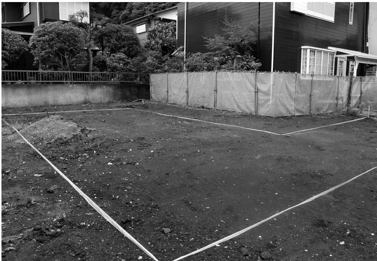
1. 調査前調査区近景（北西から）
