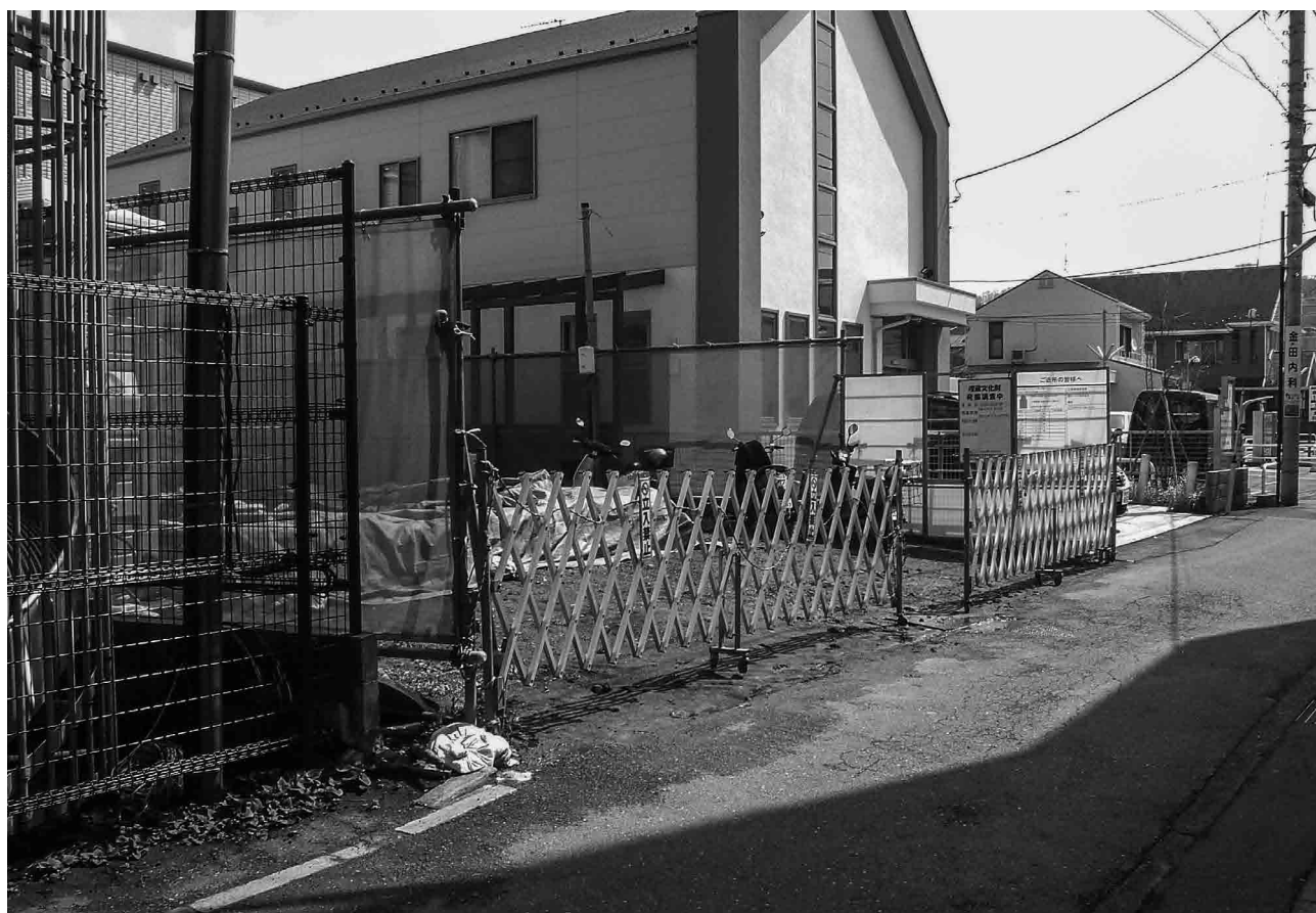
1. 調査地点近景 (西から)
