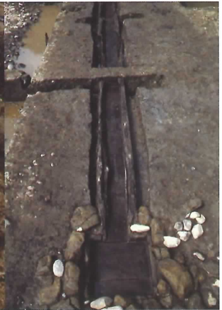
写真6 木樋と枡(②地点) (Photo 6) Gutter (Point ②)
