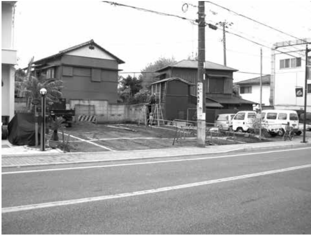
▲ A 調査地点 (北東から)
