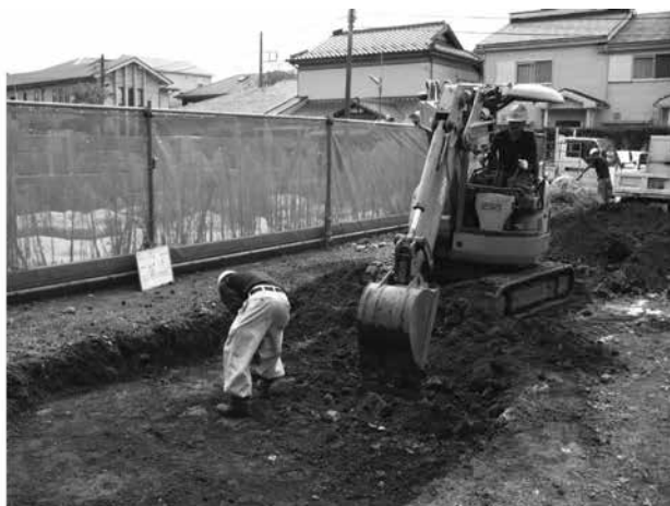
2. I区表土掘削状況 (北西から)
