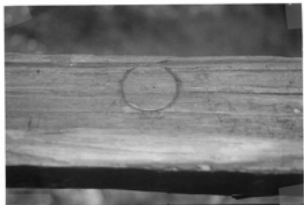
6. 側溝出土の地覆材
