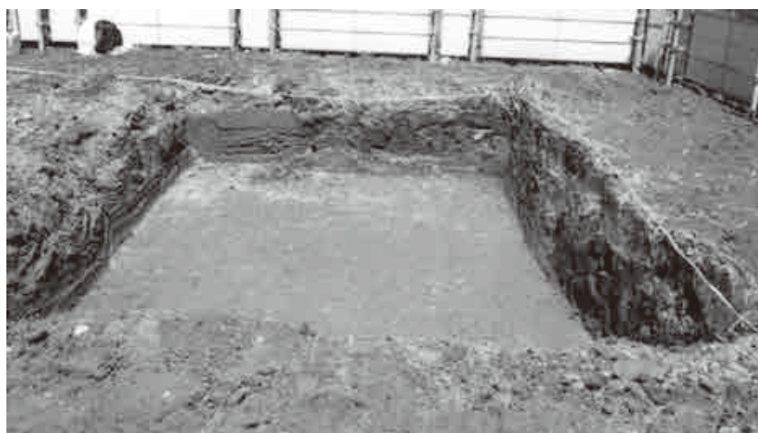
▼ C. 表土掘削後の調査区 (南から)
