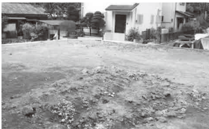
▲ B. 表土掘削前 (北西から)
