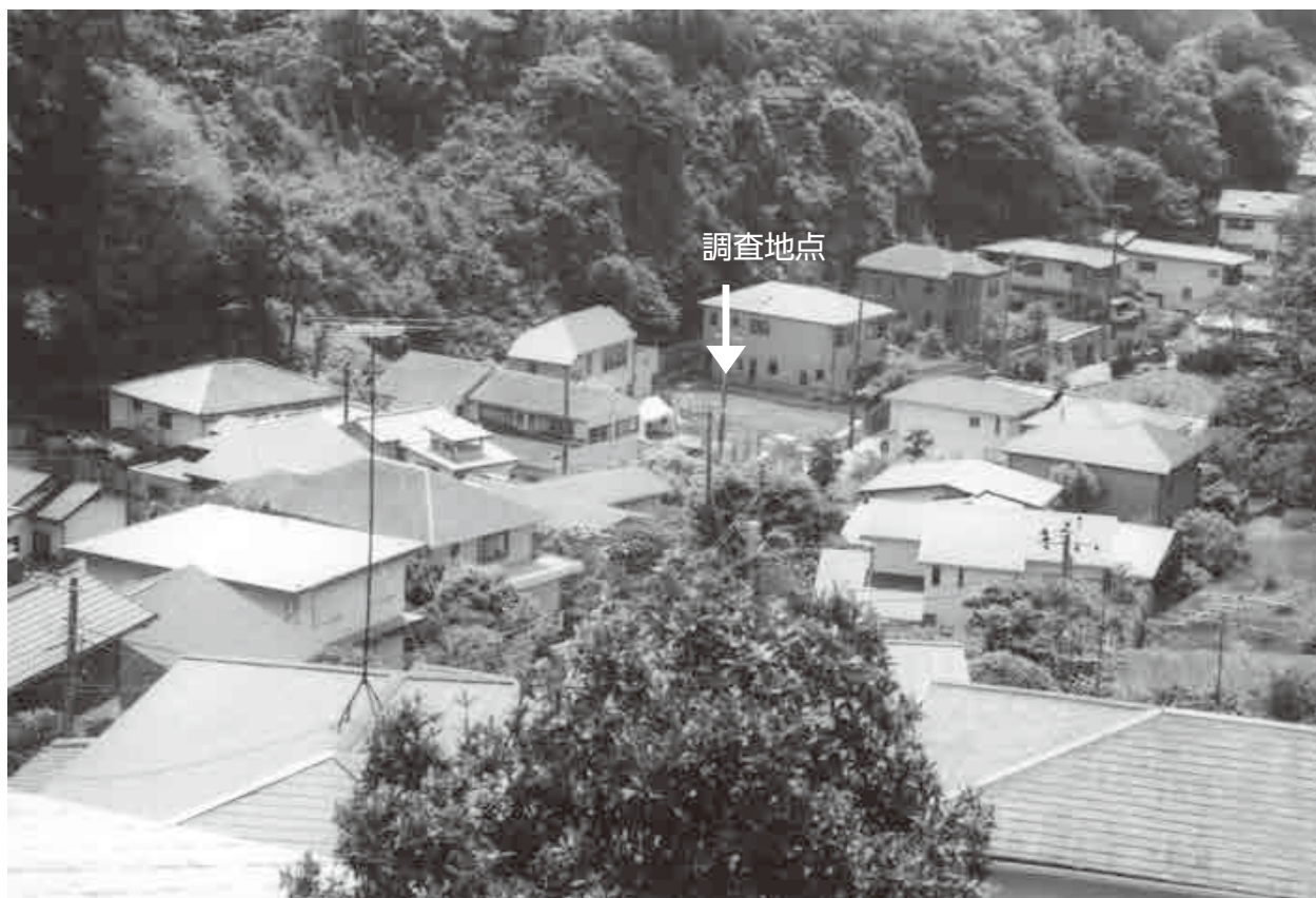
▲ A. 北方より調査区を望む
