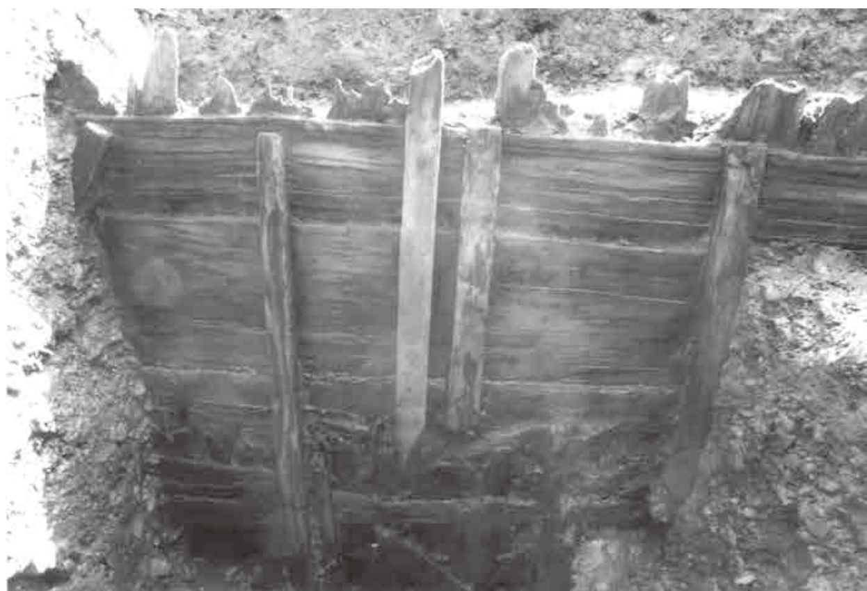
▲ B. 同上近景（北から）
