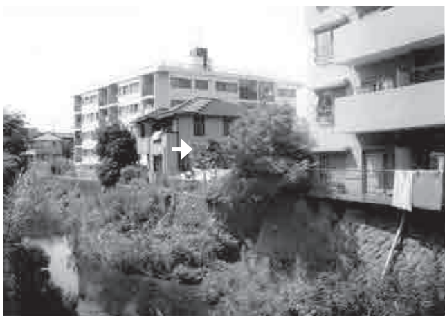
1-1 大御堂橋より調査地点を望む
